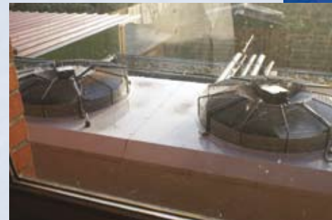
Die leise laufenden Verflüssiger fanden ihren Platz auf dem Dach.
